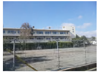
手前のグラウンドに新校舎建築
