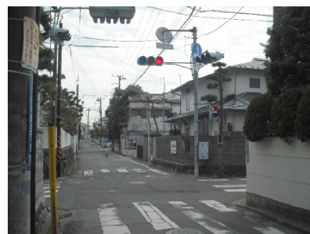
3月中旬に改良工事される中岡交差点
