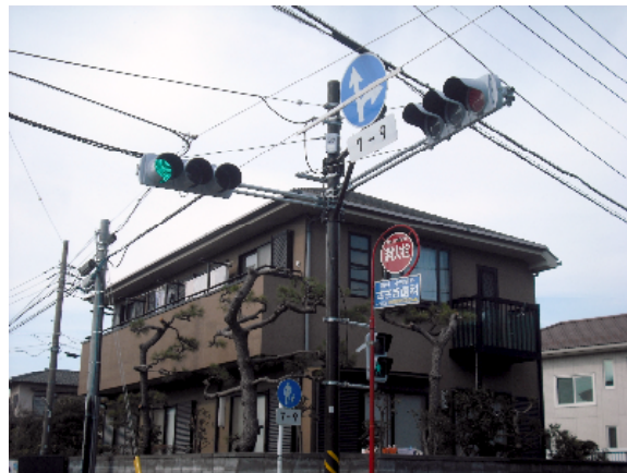
LED化され見やすくなった中岡交差点の信号機
